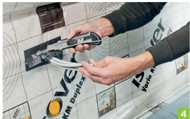
4. Anschließend einen Klebestreifen Vario® MultiTape SL von oben an das Kabelbündel kleben und dann wie in Schritt 3 beschrieben verfahren.
