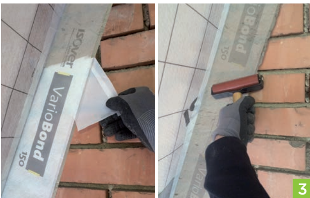
3. Danach verbleibenden Abziehstreifen von ISOVER Vario® Bond ablösen, auf den vorbereiteten Untergrund kleben und mit einem handelsüblichen Roller andrücken.
