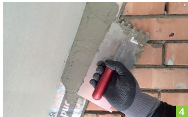
4. Trockenbauarbeiten ausführen und anschließend ISOVER Vario® Bond mit Wandputz beschichten.
