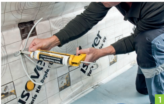
1. Die Kabel-Zwischenräume zur Abdichtung mit der Klebe-Dichtmasse ISOVER Vario® DoubleFit ausspritzen.
