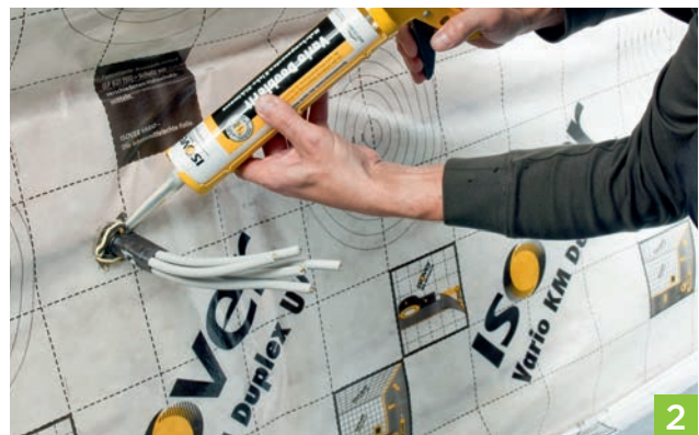
2. Alle Kabel zusammenfassen und mit Klebeband bündeln. Rings um das Kabelbündel zur Abdichtung reichlich Klebe-Dichtmasse ISOVER Vario® DoubleFit auftragen.
