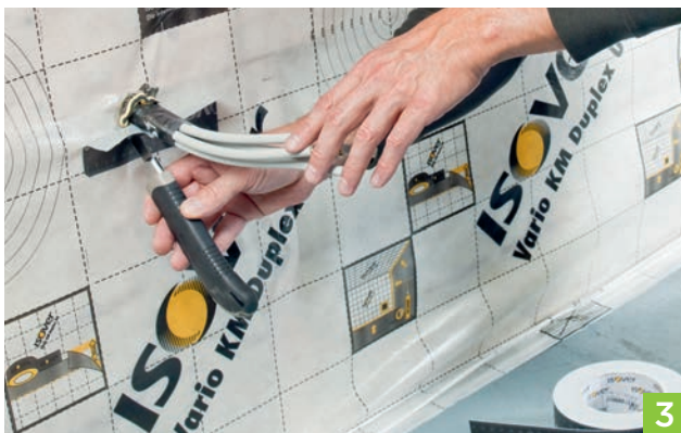
3. Von einem Streifen Klebeband Vario® MultiTape SL den Liner einer Spur lösen und das Band direkt unter den Kabelstrang kleben. Danach den Liner der zweiten Spur lösen, kabelbreit mit dem Cutter einschneiden und ankleben.
