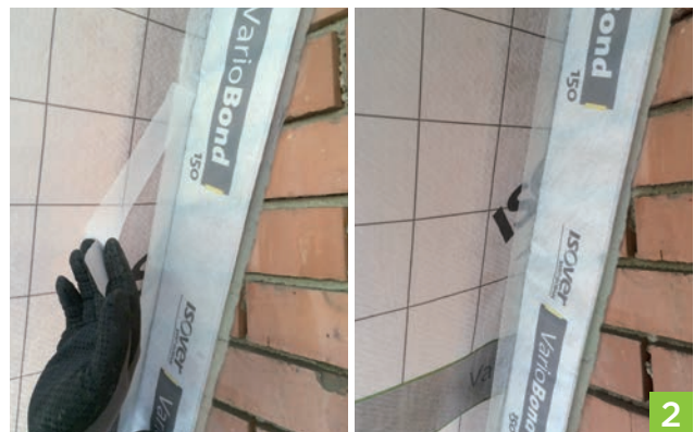
2. Geteilten Abziehstreifen an der Rückseite von ISOVER Vario® Bond ablösen. ISOVER Vario® Bond zuerst sorgfältig und luftdicht auf die ISOVER Klimamembran verkleben.
