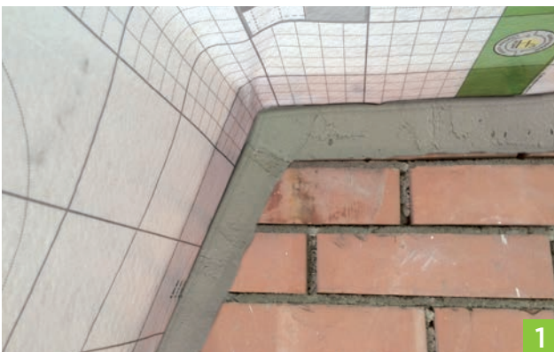
1. ISOVER Klimamembran bündig an der angrenzenden Wand abschneiden.
