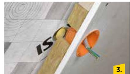
Zur parallelen Fixierung der Lattung einfach eine zugeschnittene Holzlatte als Abstandhalter verwenden. Die Lattenabstände orientieren sich an den Vorgaben der InnenbekleidungsHersteller, maximal jedoch 500 mm Rastermaß.
