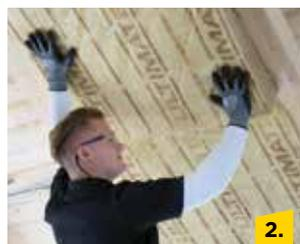
2. Zugeschnittenen Dämmfilz zwischen die Sparren klemmen. Auf fugendichten Anschluss achten.
