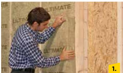
Bei einem Rastermaß von 625 mm kann die Dämmung einfach und zeitsparend direkt in das Gefach ausgerollt werden. Bei abweichenden Maßen ULTIMATE Holzbaufilz mit einer Klemmzugabe von 10 mm zuschneiden.
