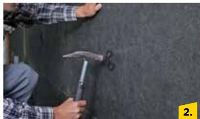
2. Die Platten werden mit 5 Dämmstoffhaltern pro  $\text{m}^2$  an der tragenden Wand befestigt.
