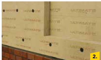
Anschließend mit Abtropfscheiben fixieren. Auf dichte Plattenstöße achten.
