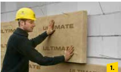
Mauerwerksanker in die waagerechten Fugen der Steine einbauen. Die ULTIMATE Kerndämmplatte-035 wird daraufhin auf die Mauerwerksanker geschoben.
