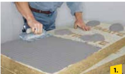
Klebmontage: ISOVER Klebemörtel mit gezahntem Kammspachtel (10 mm) vollflächig mit leichtem Druck auf die Rückseite der Deckenplatte auftragen. Die seitlichen Kanten bleiben kleberfrei.
