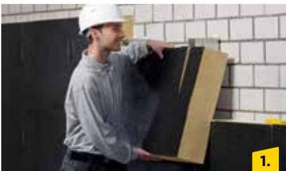
1. Unterkonstruktion aus Aluminium. Die Dämmung wird flächig verlegt und über die Haltewinkel an der Wand geschoben.
