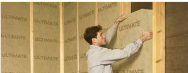
ULTIMATE Holzbauplatte-035 einfach in das Gefach einstellen und festdrücken, sodass keine Hohlräume zwischen Dämmung und Beplankung verbleiben. Wichtig: die Plattenkanten dicht anschließen, damit keine Wärmebrücken entstehen.
