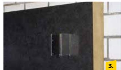
3. An den über die Vorderseite der Dämmplatte hervorstehenden Haltewinkeln werden Tragprofile zur Befestigung der Fassadenbekleidung montiert.
