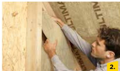
ULTIMATE Holzbaufilz ist so flexibel, dass die Dämmung ganz nach Bedarf in die Gefache geklemmt werden kann.
