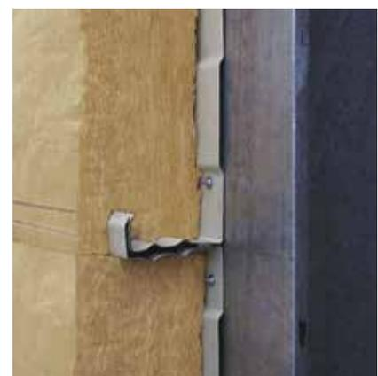
ISOVER Metac WS dämmt nach oben und nach unten gerichtete Kassettengurte gleichermaßen gut.
