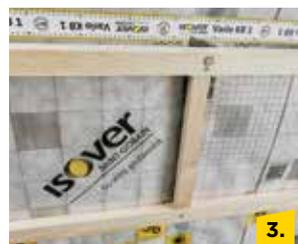
3. Vario® Klimamembran fachgerecht einbauen und Unterkonstruktion zur Lagefixierung (z.B. Lattung) anbringen.
