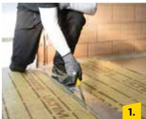
1. Klemmfilz ausrollen, lichten Sparrenabstand plus 10 mm Klemmzugabe abmessen und abschneiden.
