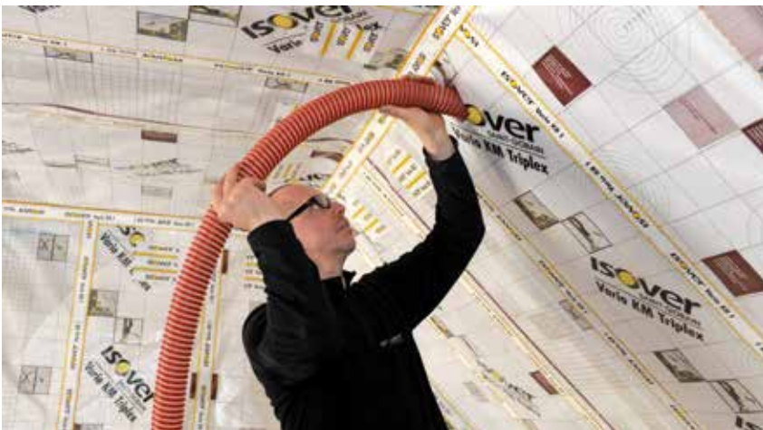
Verarbeitung im Steildach und in der Holzriegelwand, eingeblasen hinter ISOVER Vario® Triplex Klimamembran
