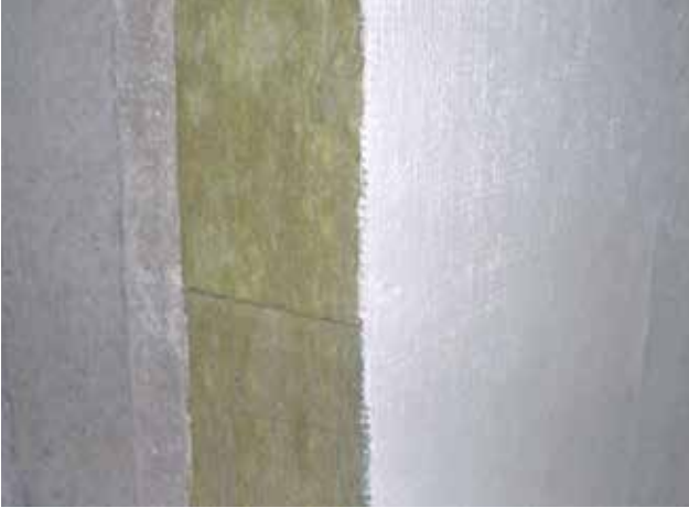
Wand: Topdec Universal, geklebt + gedübelt, gespachtelt
