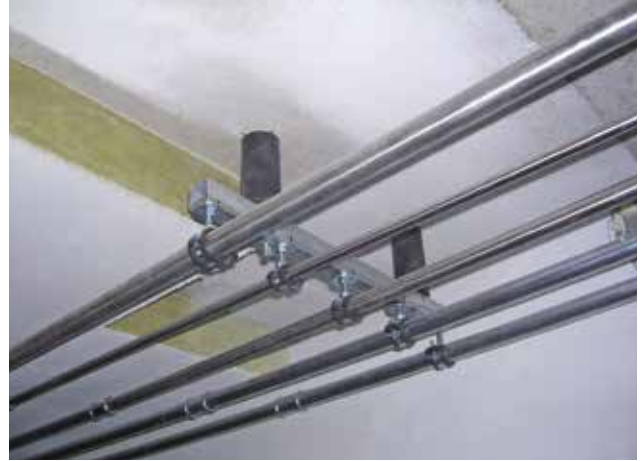
Decke: Topdec Universal, geklebt + gedübelt, gespachtelt
