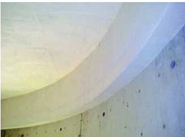
Decke + Flanke: Topdec Universal, geklebt + gedübelt, gespachtelt
