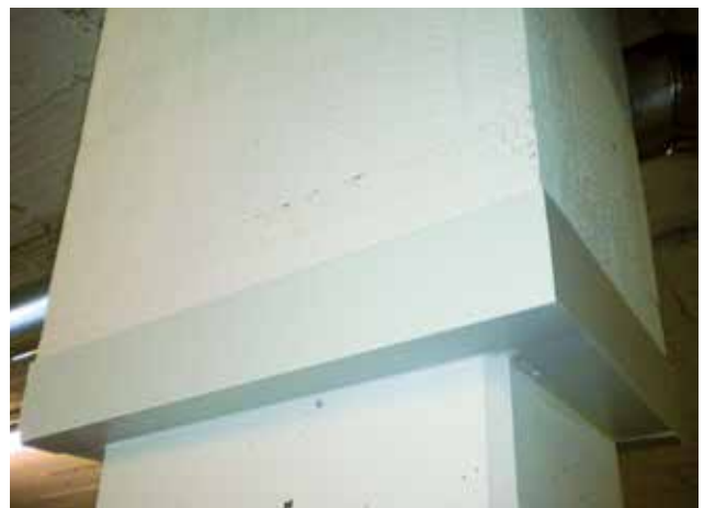
Stütze: Topdec Universal, geklebt, farbbeschichtet
