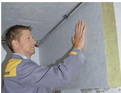
Empfehlung: Flankendämmung der Kellerwände mindestens in Plattenbreite (hier Topdec DP 3)
