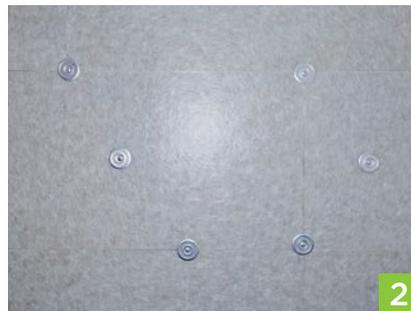
2. Beim Befestigen des Dübels sollte darauf geachtet werden, den sogenannten „Matratzen-Effekt“, verursacht durch zu tiefes Einschrauben des Dübels, zu vermeiden.
