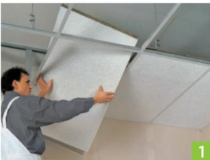
1. Die Montage des Schienensystems ist nach Herstellerangaben auszuführen. Bei der Wahl der Abhängehöhe sollte ausreichend Platz verbleiben, um die gewünschte Plattendicke einlegen zu können. Zur Vermeidung von Verschmutzungen der Sichtoberfläche auf saubere Finger und Handschuhe achten!
