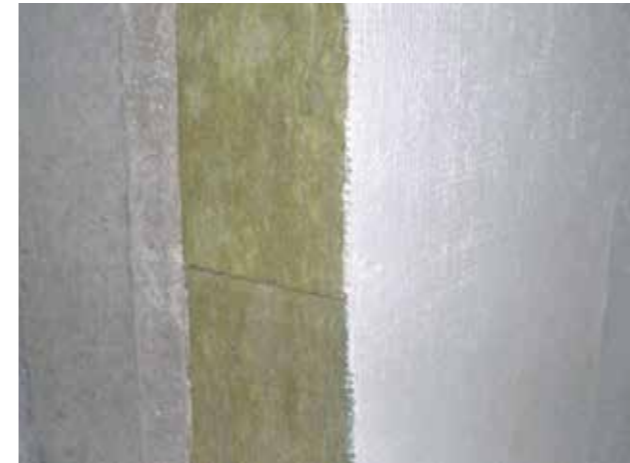
Wand: Topdec Universal, geklebt + gedübelt, gespachtelt
