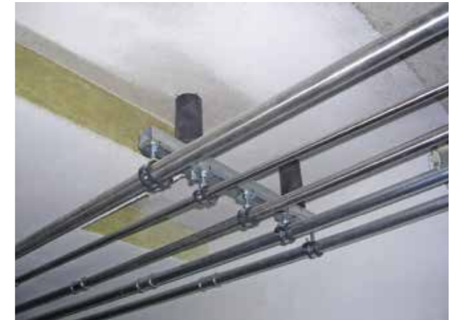
Decke: Topdec Universal, geklebt + gedübelt, gespachtelt
