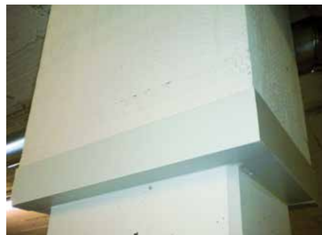
Stütze: Topdec Universal, geklebt, farbbeschichtet
