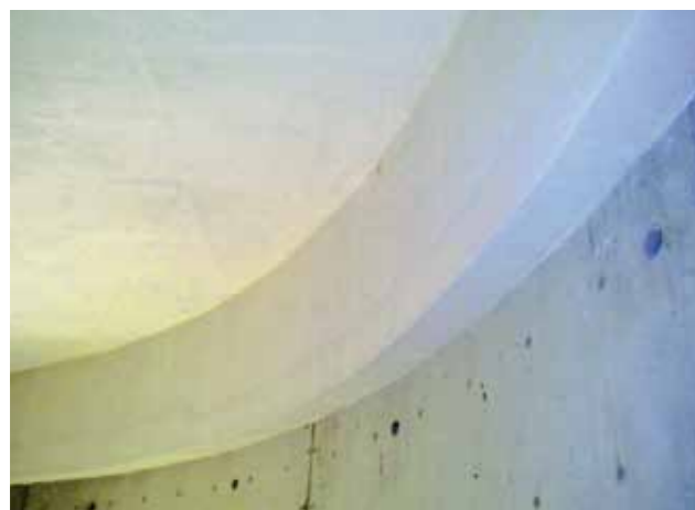
Decke + Flanke: Topdec Universal, geklebt + gedübelt, gespachtelt
