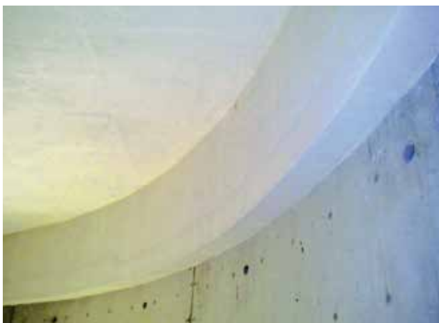
Decke + Flanke: Topdec Universal, geklebt + gedübelt, gespachtelt
