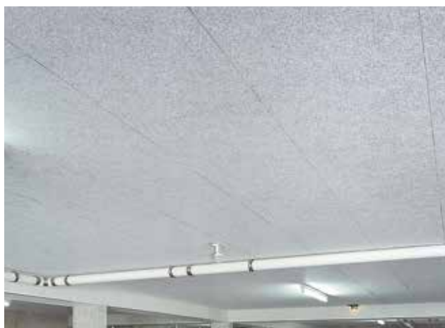
Topdec DP 1 struktur, geklebt
