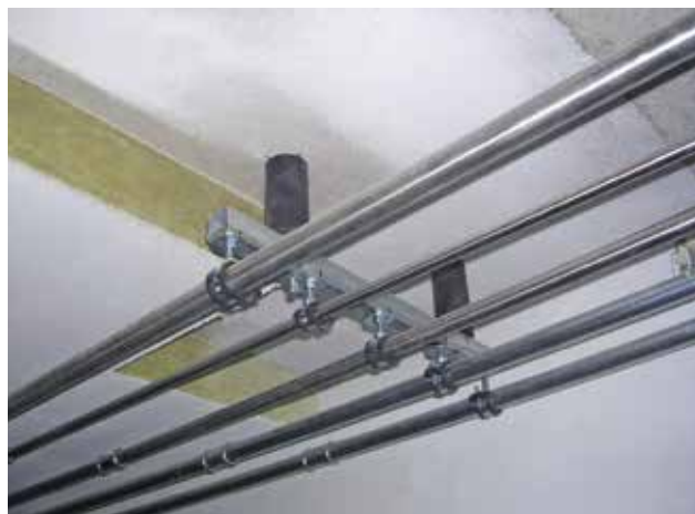
Decke: Topdec Universal, geklebt + gedübelt, gespachtelt
