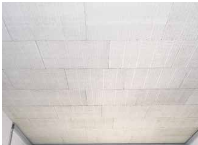
Topdec Universal, geklebt, unbeschichtet
