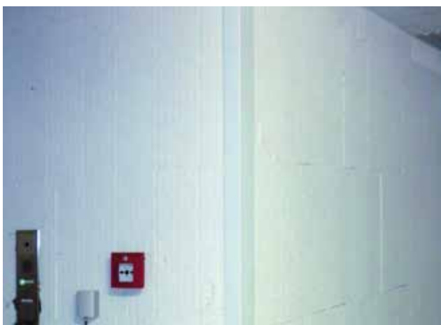
Wand: Topdec Universal, geklebt, farbbeschichtet
