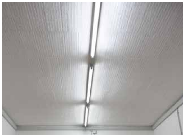
Topdec Universal, geklebt, farbbeschichtet
