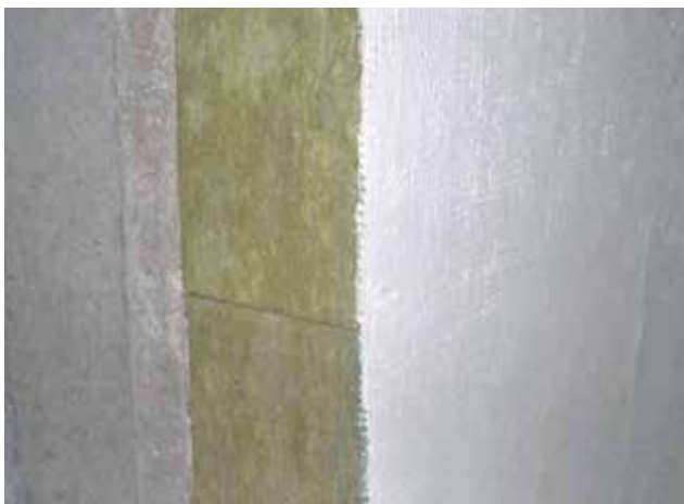
Wand: Topdec Universal, geklebt + gedübelt, gespachtelt
