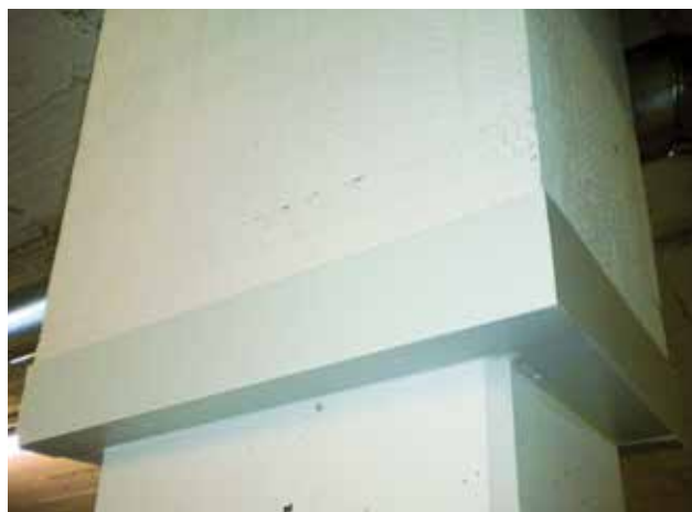
Stütze: Topdec Universal, geklebt, farbbeschichtet
